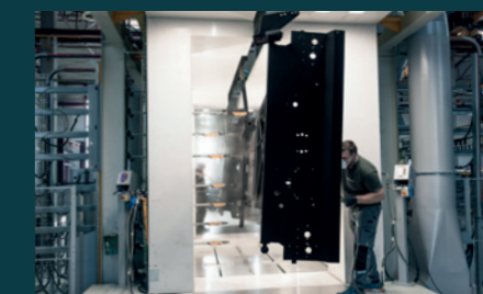
Automatyczne malowanie proszkowe
