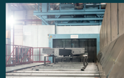
Mechaniczna obróbka strumieniowo-ścierna w celu uzyskania czystych i jednorodnych powierzchni
